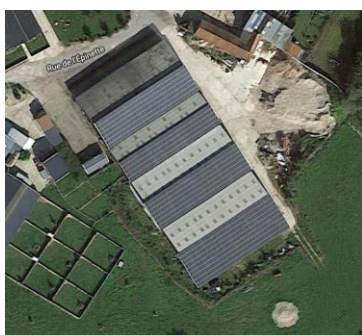
Toiture PV agricole à Bellancourt 2
