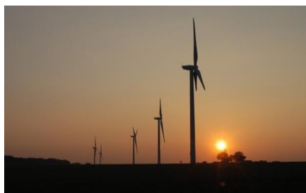
Parc éolien Les Monts Bergerons II 1
